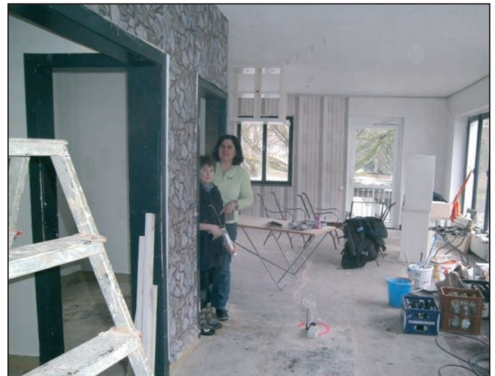
Die „noch“Baustelle „Zur Quelle“ mit Constanze Sper und Sohn
