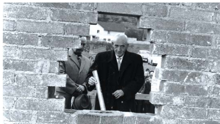
Bürgermeister Bauer legt in einer versiegelten Bleikapsel die Urkunde und Zeitzeugnisse in den Grundstein ein. (Bild Jupp Schuld)
