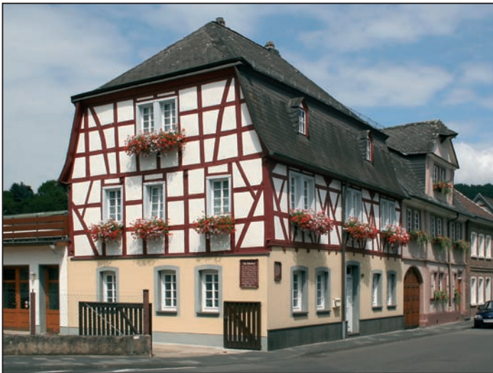
Wohnhäuser Nr. 122 u. 124 in der Hauptstr. Foto: Erhardt
