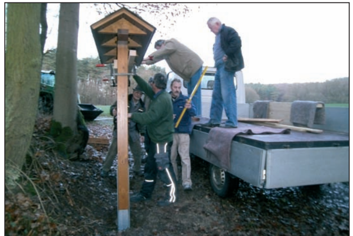
Hilfe beim Aufstellen des Rahmens für die Tafel
