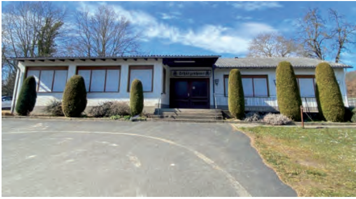
Die Schützenhalle in Bad Bodendorf könnte bald zum Dorfgemeinschaftshaus werden. (Foto: HBlechen)
