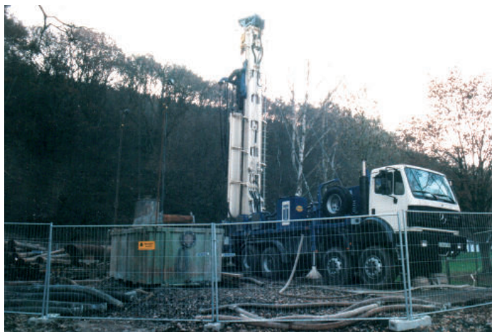
1995, die Firma Harless Pickell/Consult bei der Sanierung der Quelle
